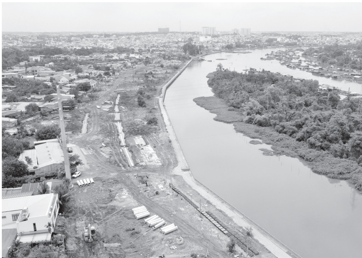
Tiến độ thi công Dự án Đường ven sông Cái được đẩy nhanh trong hơn một tháng vừa qua.
