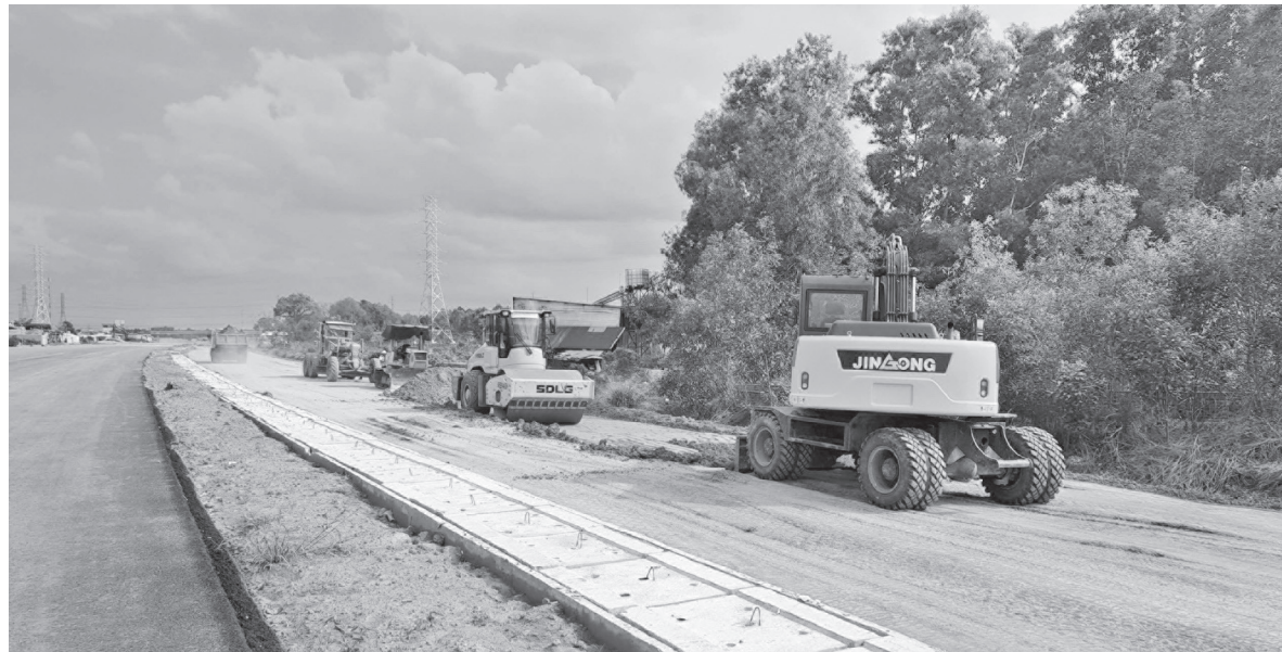
Thi công hệ thống đường gom, đường song hành tuyến đường vành đai 3 - Thành phố Hồ Chí Minh đoạn qua địa bàn thành phố Đồng Nai.
